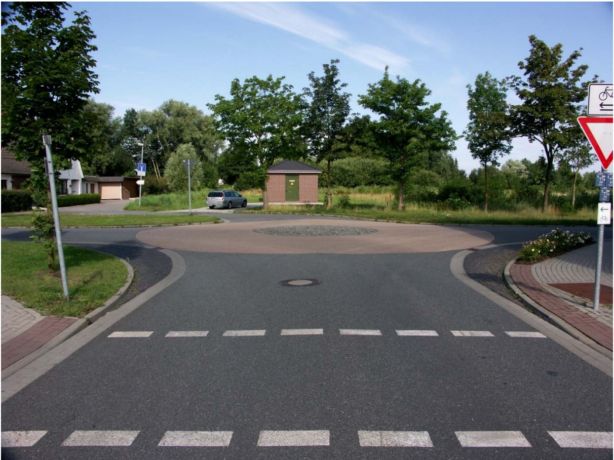
Stadtteileingangsbereich An den Wurten/Am Salzendeich (nachher)
