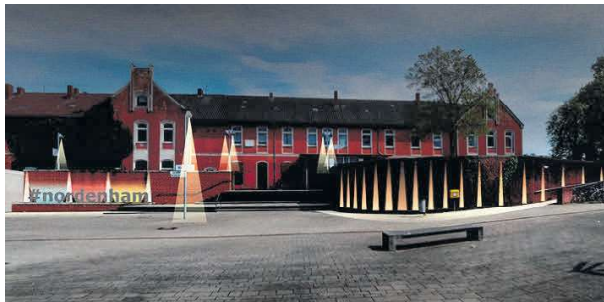
So soll die Flutmauer vor dem Bahnhof in den Abendstunden beleuchtet werden.
