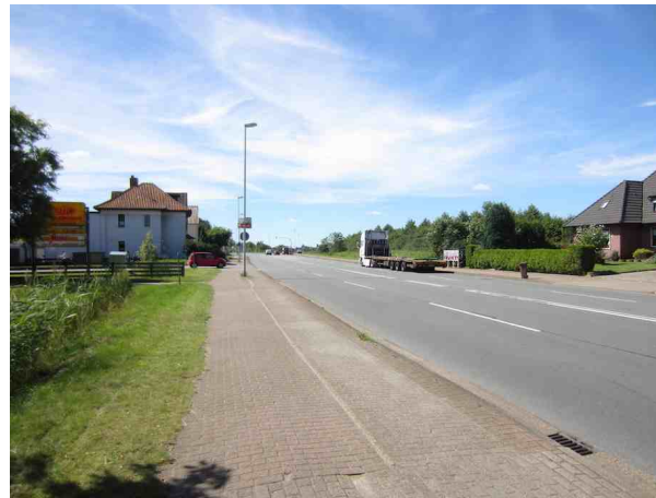
Lange Straße Blickrichtung Südwest: Einfahrtsituation zum Projektgrundstück
