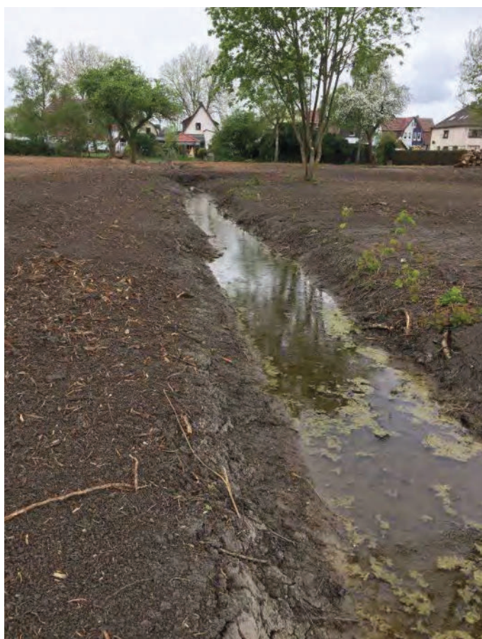
Abbildung 3: Vegetationsfreier Graben im B-Plan-Gebiet nach Beräumung der Fläche; April 2019
