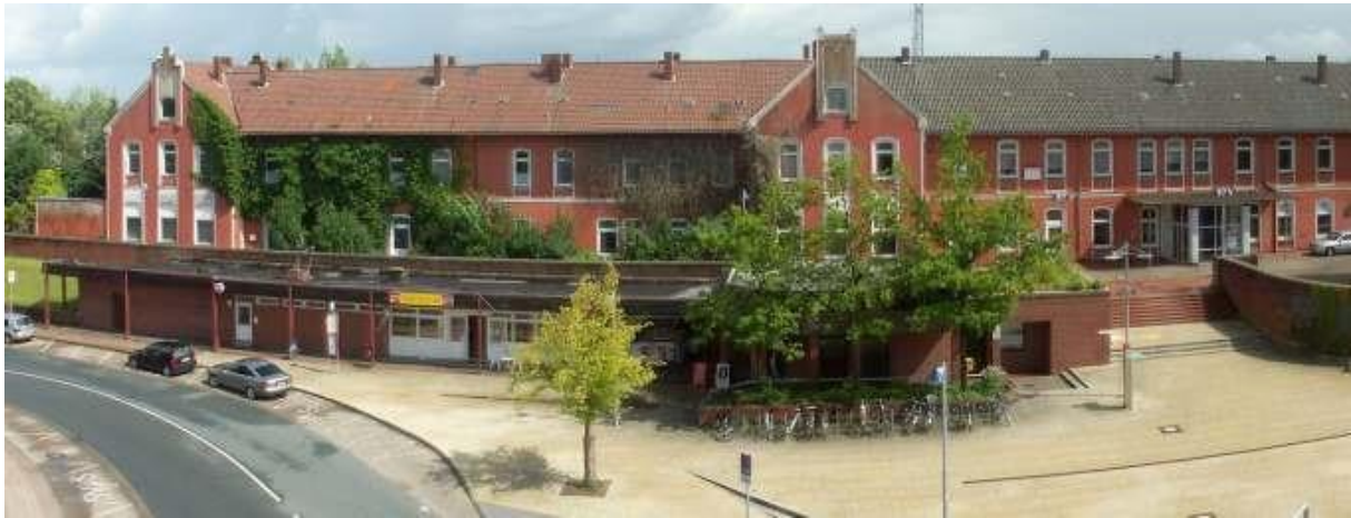
Bahnhofsvorplatz mit ehemaliger Milchbar/Imbiss und öffentlichem WC, 2016
