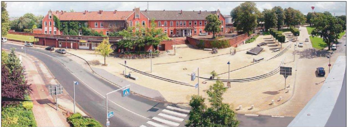
Der Bahnhofsvorplatz soll im Zuge der City-Süd-Sanierung attraktiver gestaltet werden. Die Flachdachzeile ist ein Fall für den Abrissbagger. BILDER: TIM LORENZ
