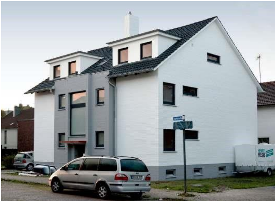
Gebäude Karlstr. 21, Zustand 2014
