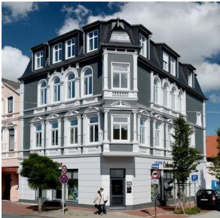
Gebäude Bahnhofstr. 10, Zustand 2014
