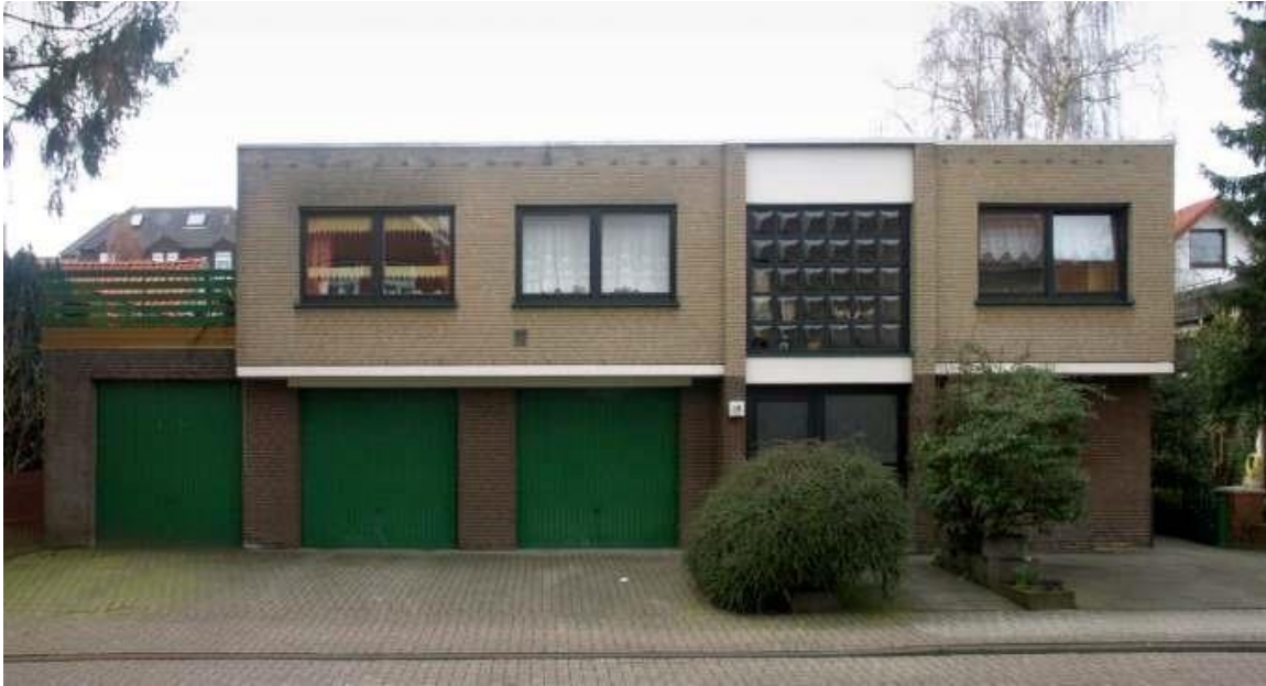
Gebäude Peterstr. 16, Zustand 2015
