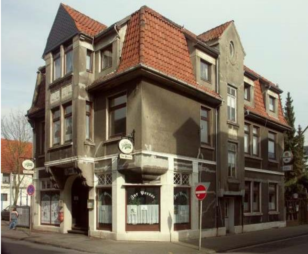
Gebäude Karlstr. 12, Zustand 2009
