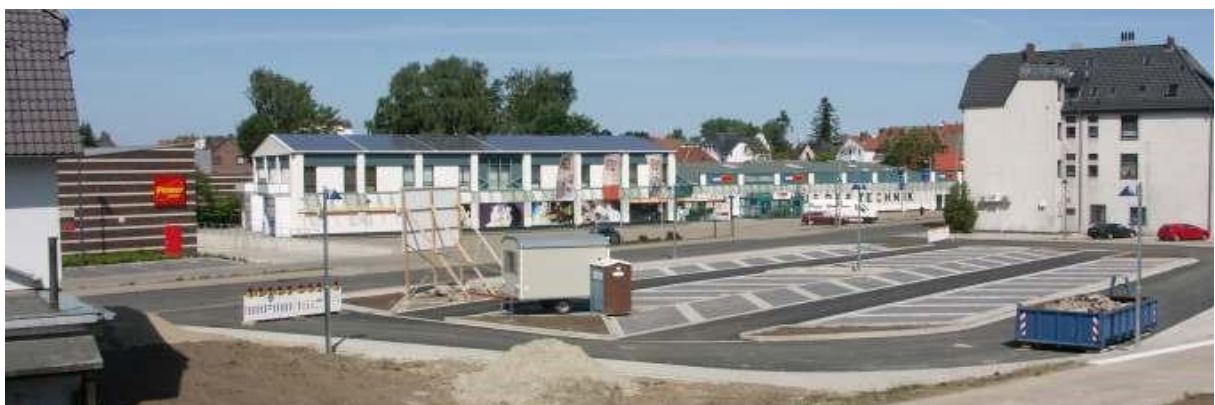
Grundstück Deichgräfenstr. 8, Sanierung 2011
