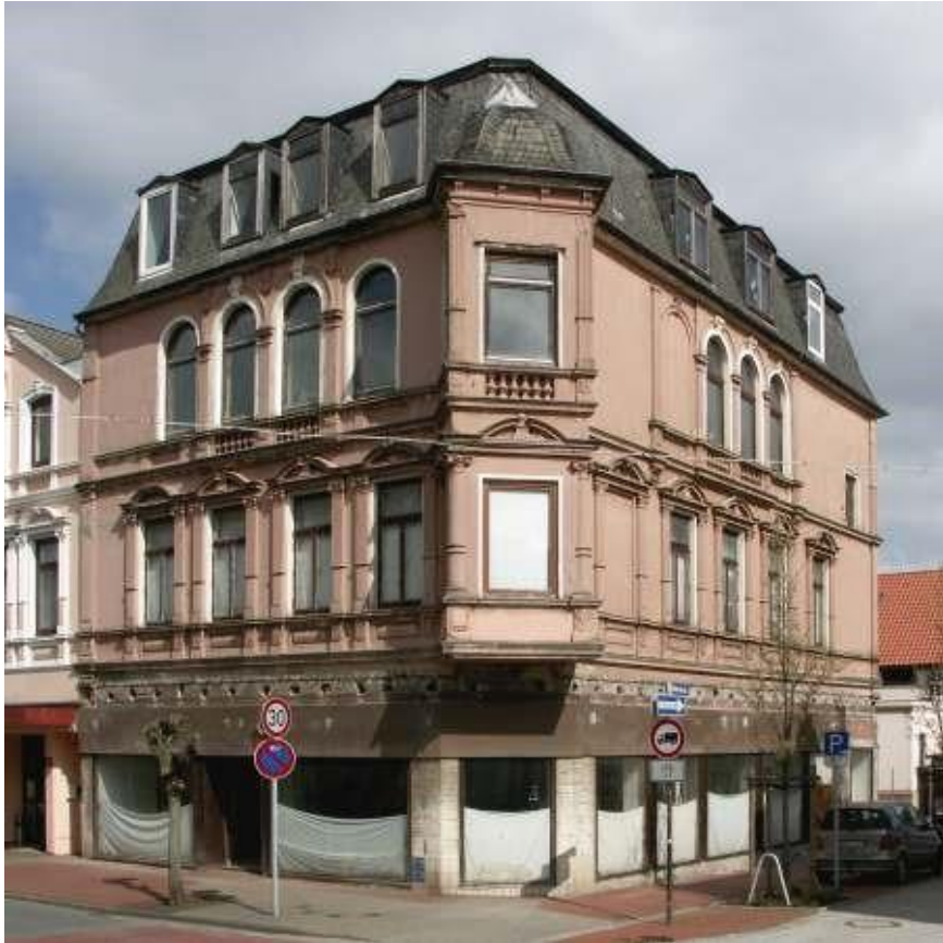
Gebäude Bahnhofstr.10, Zustand 2013
