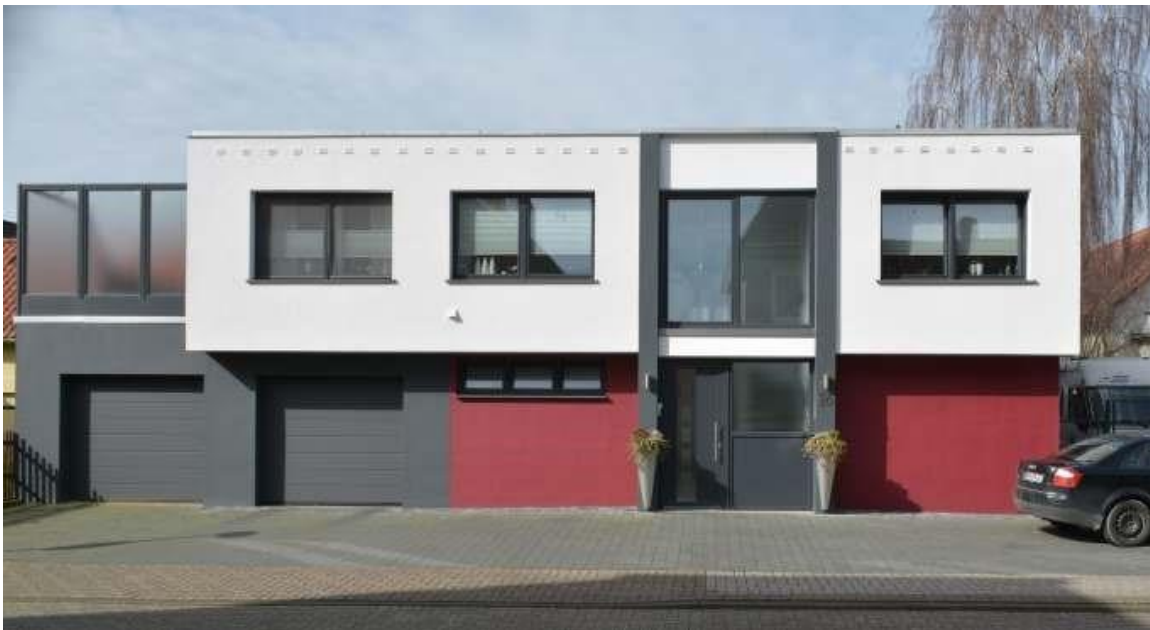
Gebäude Peterstr. 16, Zustand 2016
