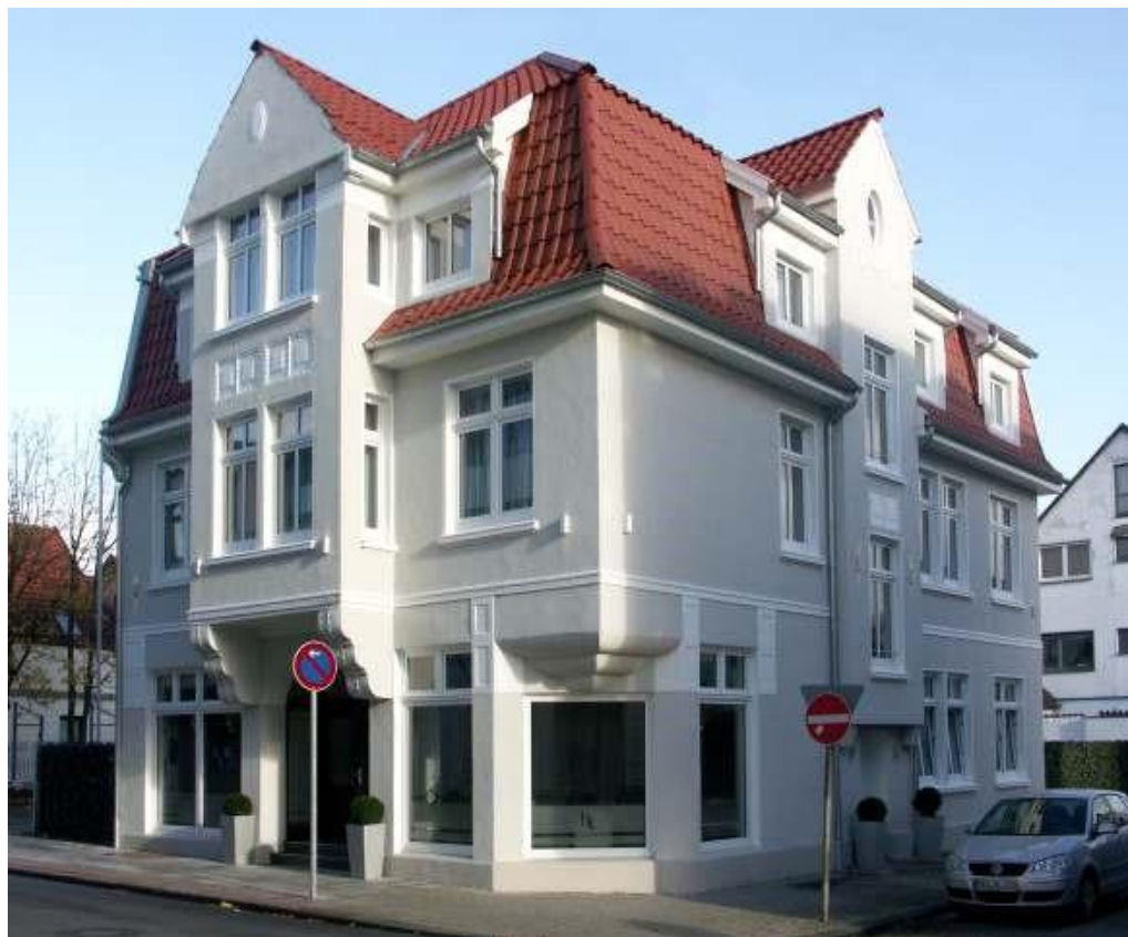
Gebäude Karlstr. 12, Zustand 2010
