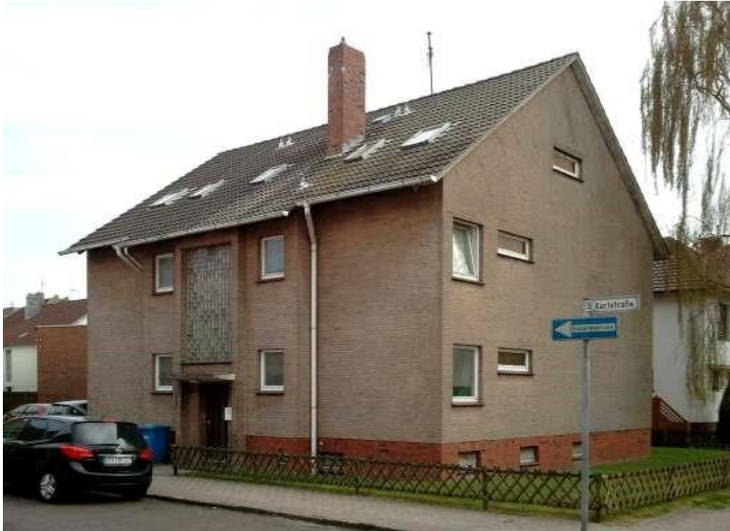
Gebäude Karlstraße 21, Zustand 2013
